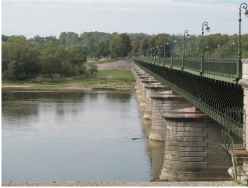
Le Pont Canal de Briare
